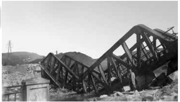
Železničný most na Chvatimechu, po prechode frontu
