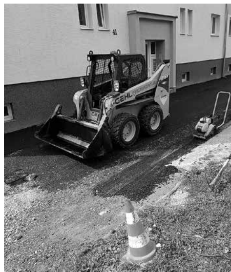
Rekonštrukcia asfaltovej plochy pred bytovým domom SČ 453 na ulici TDH
