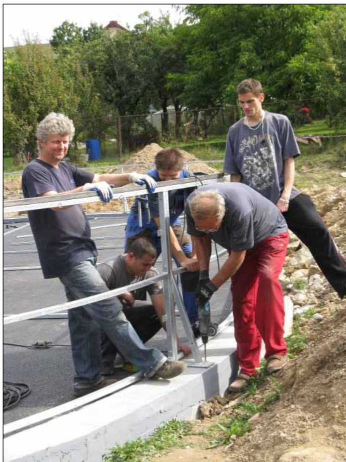
MONTÁŽ KOVOVEJ KONŠTRUKCIE PRE MANTINELY
