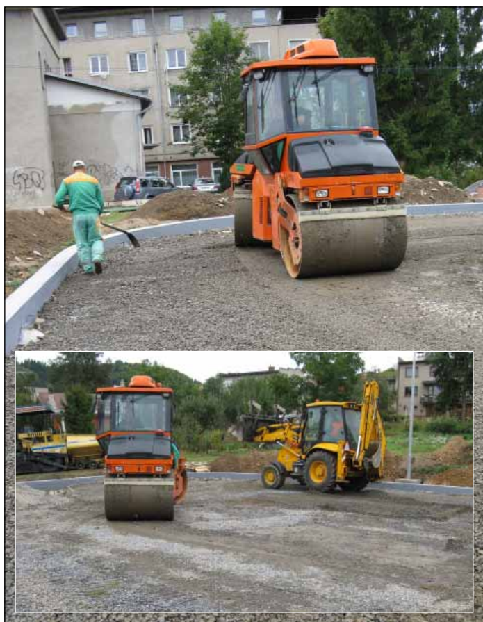
VYROVNÁVANIE PODKLADU POD ASFALTOVÚ PLOCHU
