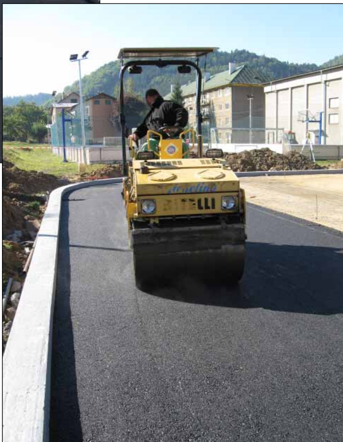
VALCOVANIE ASFALTOVEJ PLOCHY
